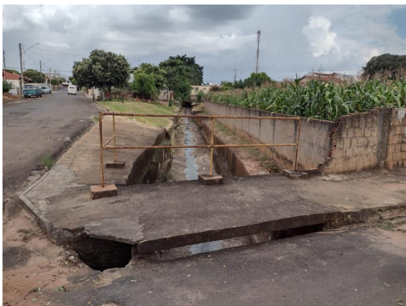
Figura 9. Demonstração da calha do córrego drenada em seu trecho urbano.
